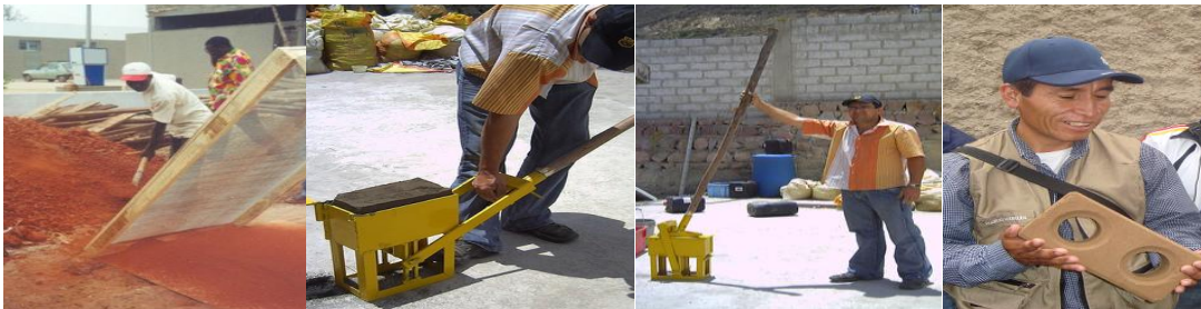
Foto: Inicio de la construcción de las viviendas, en el Norte de Potosí
