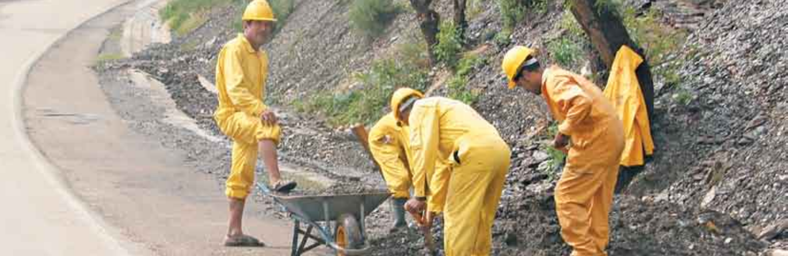
Un grupo de trabajadores del sector Caminos realiza obras de mantenimiento en una ruta interdepartamental, durante la época de lluvias.
