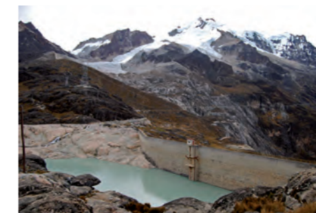
En noviembre de 2009, la represa del Tunir registró una baja en su capacidad de almacenamiento de agua hasta en un 82%
