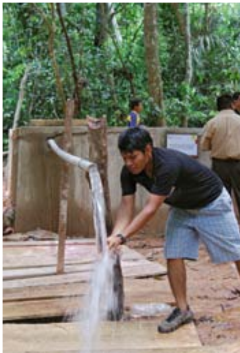
Construcción de embalse para sistema de agua en el Cebú-Beni
