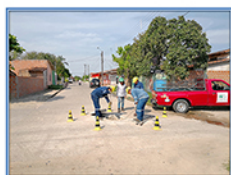
Personal técnico abriendo cámara de inspección, previa señalización de la zona de trabajo
