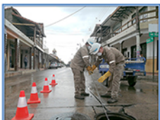
Limpieza del colector principal hecha por personal con equipo de protección individual
