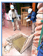
Taponamiento de cámaras de inspección
